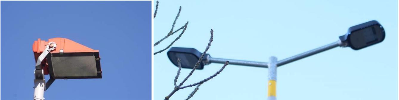
Wurden bei der alten Beleuchtung mustergültig voll abgeschirmte asymmetrische Planflächenstrahler benutzt, sind die neu installierten LED-Leuchten (rechtes Bild) geneigt mit schlechter Lichtlenkung montiert.
